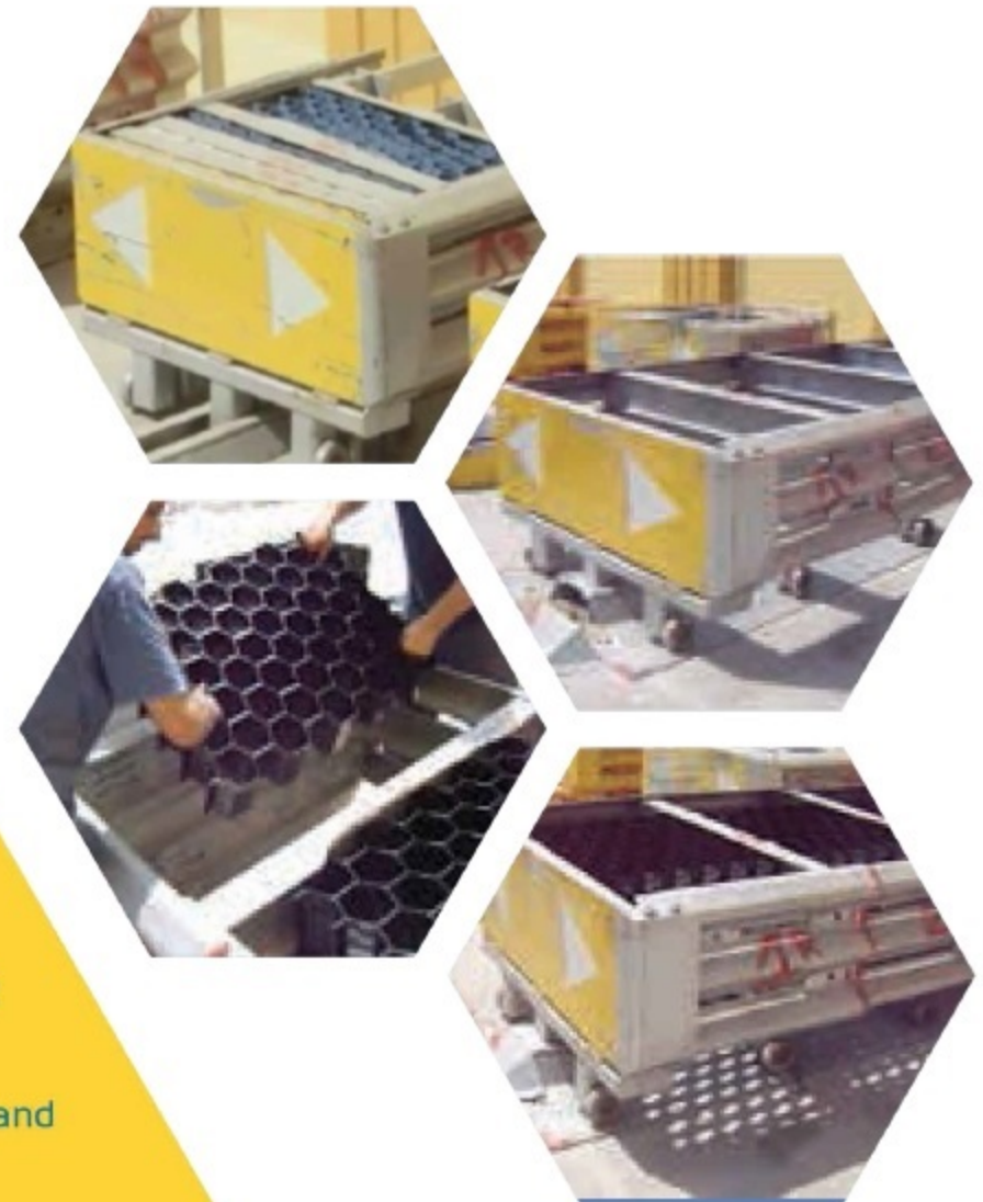
Ripristino attenuatori d'urto SMA 80 dopo crash test.
